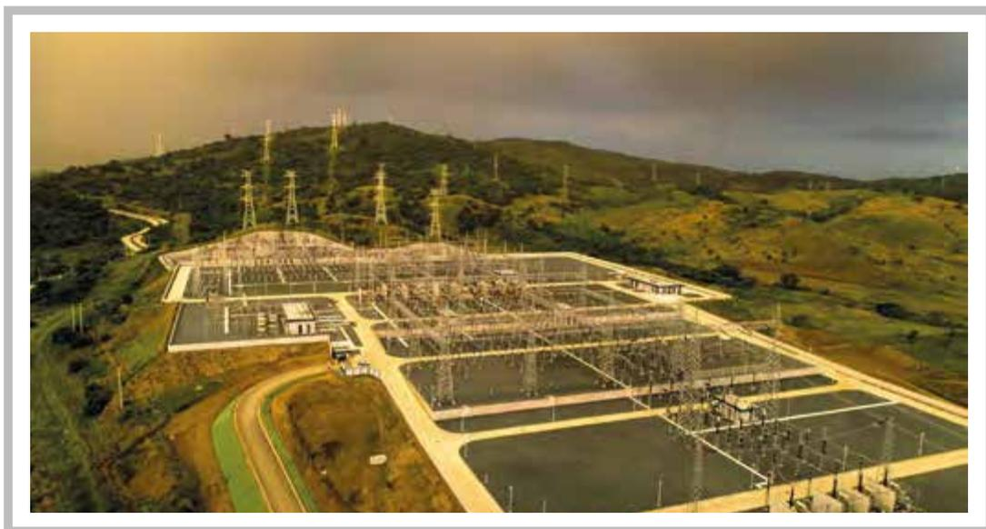
La Subestación Chorrillos es parte del Sistema de Transmisión a 500 kV, que consiste en 900 kilómetros de líneas que pasan por doce provincias de Ecuador.
